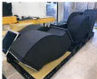
保温材貼付施工
