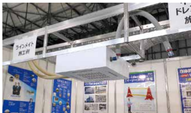
天井にはラインメイト施工例／イージードレンホース施工例
