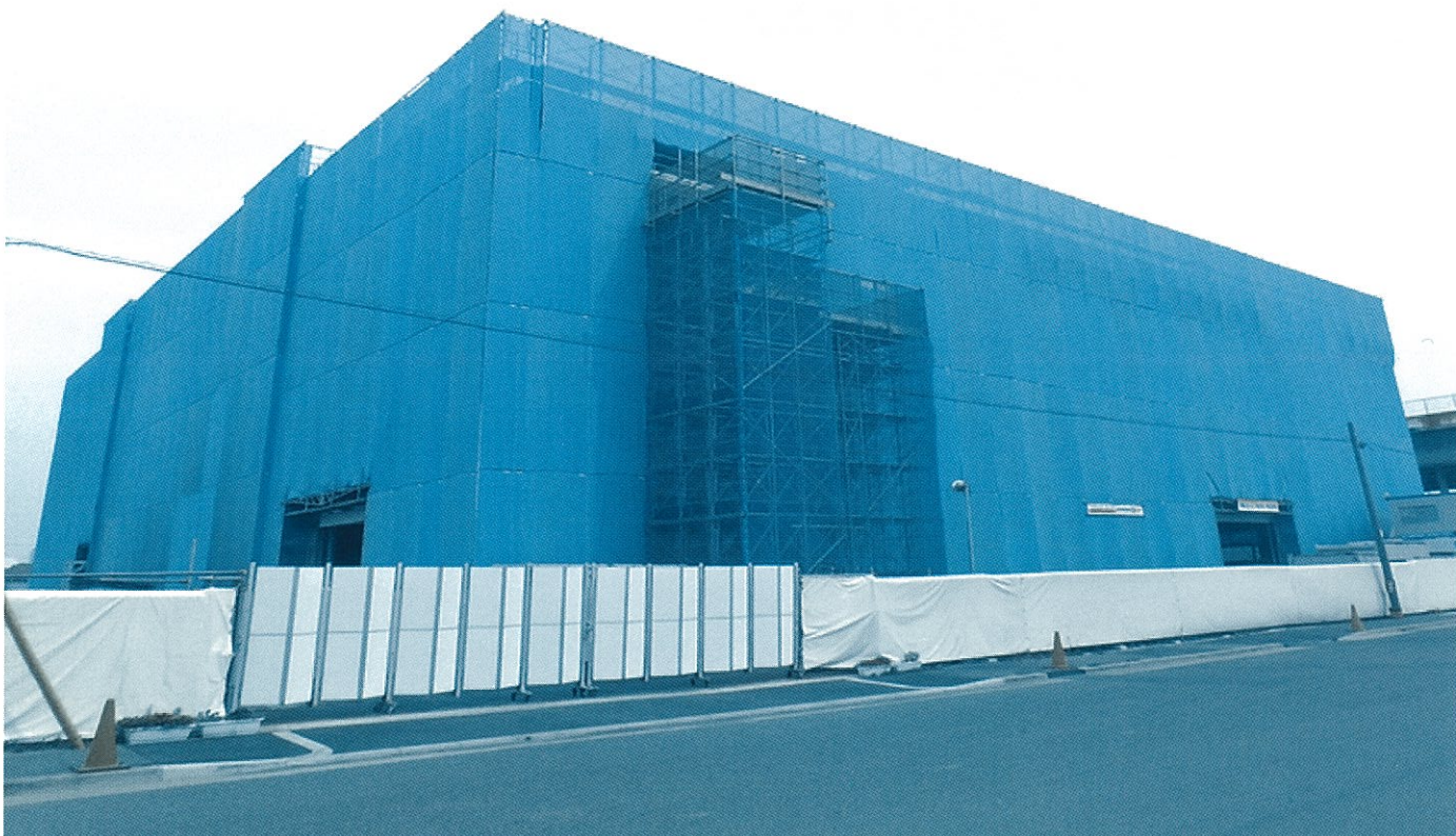
平成29年5月30日撮影（完成予定地：大阪市大正区三軒家東3丁目）
