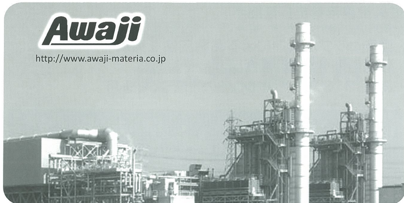
火力発電所(千葉県袖ヶ浦市・溶接式管継手採用)
